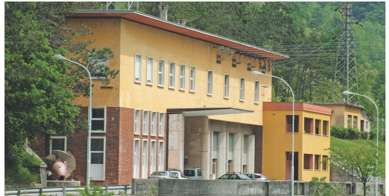
Strojnica hidroelektrarne Plave
