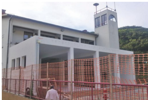
Gradnja podaljška garaž
