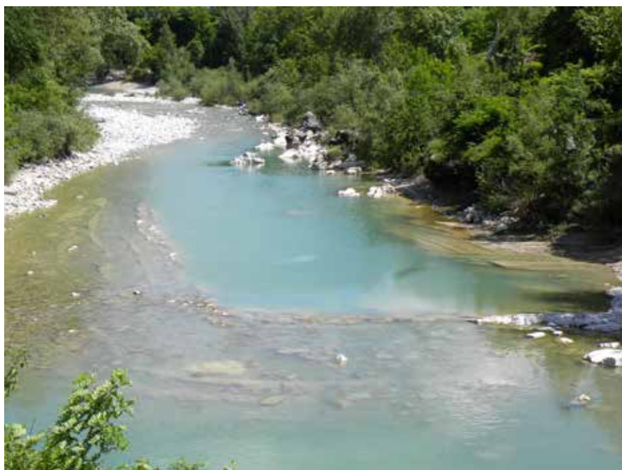
Zanimivo obrušene plasti krednega fliša
