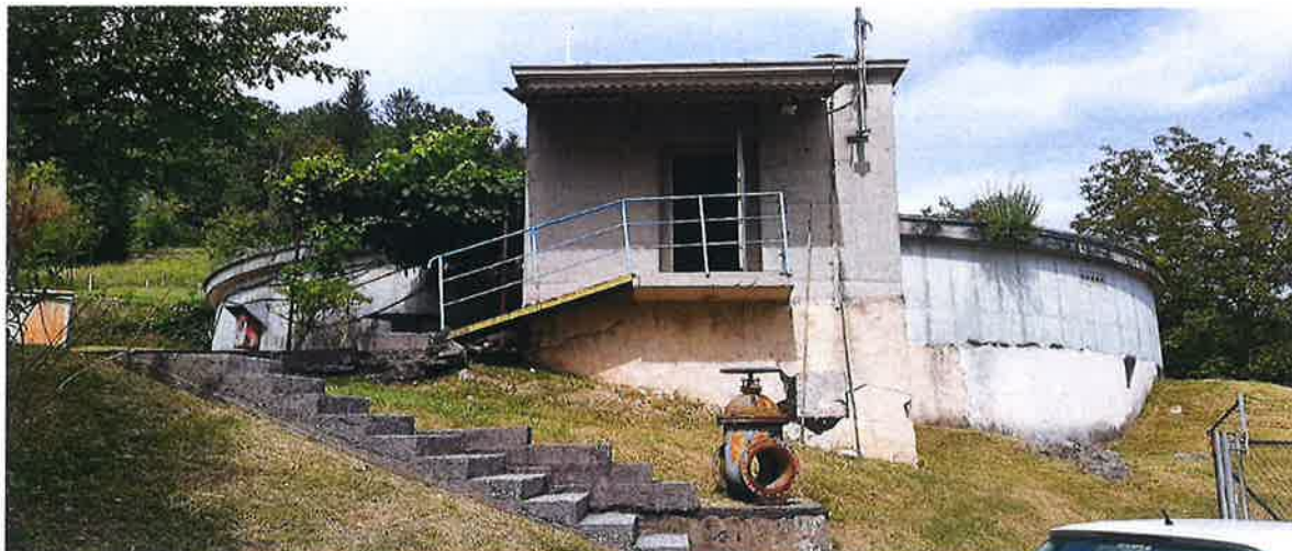
SLIKA 3: VODOHRAN ZA TEHNOLOŠKO VODO-SALONIT PRI VODARNI MOČILA
