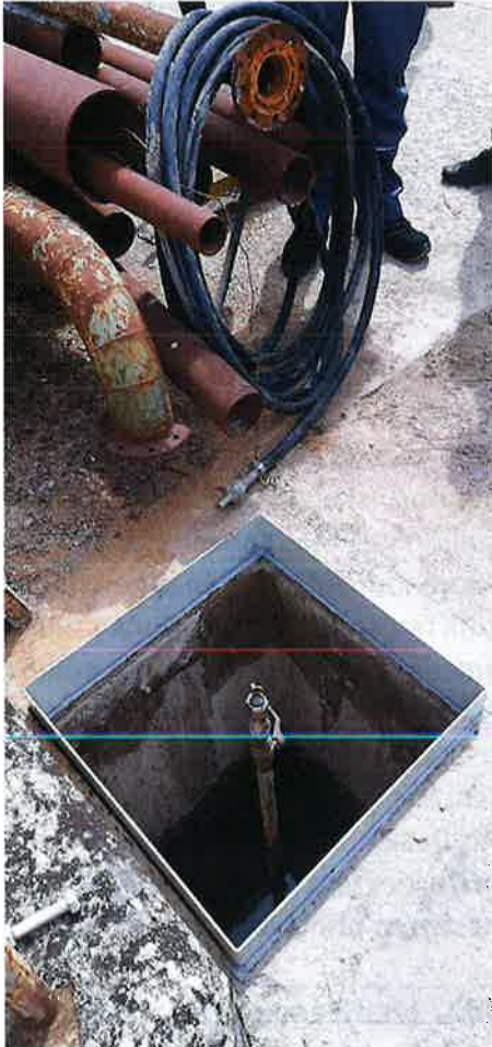
SLIKA 1: FLEKSIBILNA CEV PRI JAŠKU S PITNO VODO NA ČISTILNI NAPRAVI-ETERNIT
