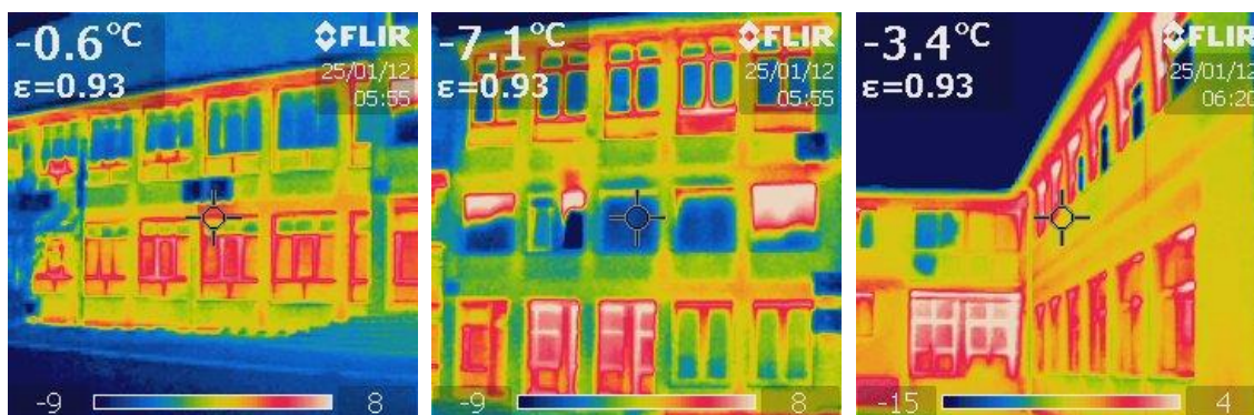
Slika 23: OŠ Kanal – fasada in okna
